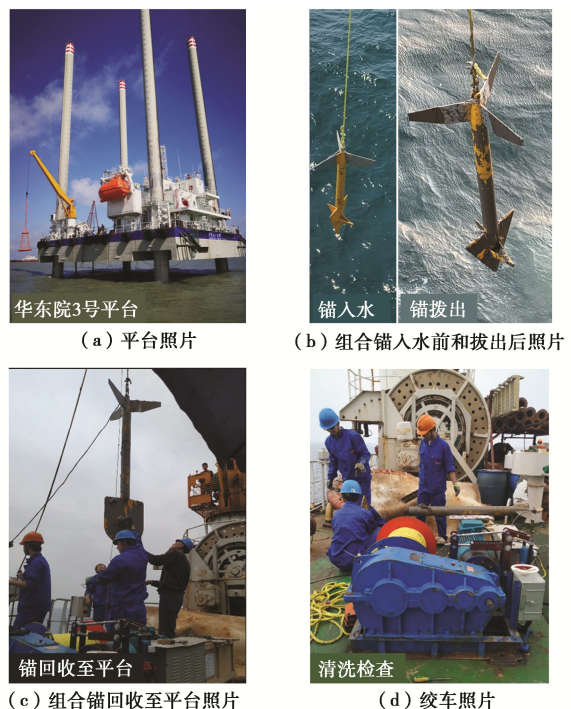
图3 组合锚动力贯入试验照片
