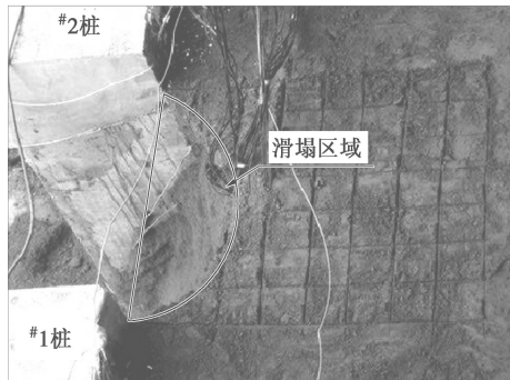
图1 悬臂桩间土体失稳试验现象
