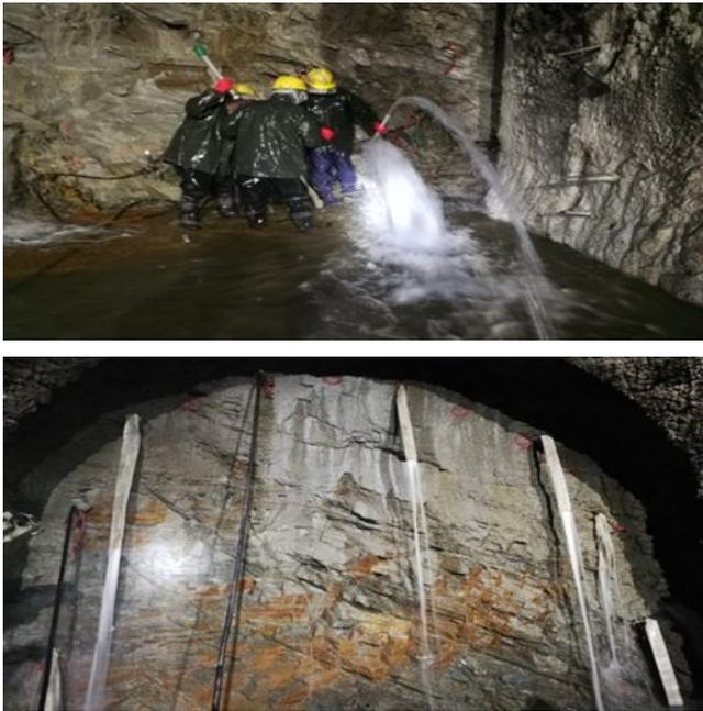
图 56 快速封堵前后的掌子面围岩出水情况
