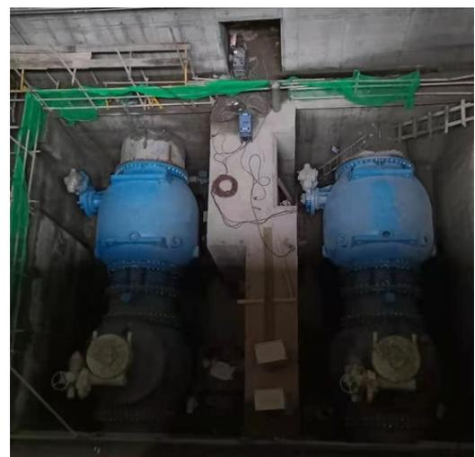
图 52 三河口水利枢纽 DN2000 流量调节阀
