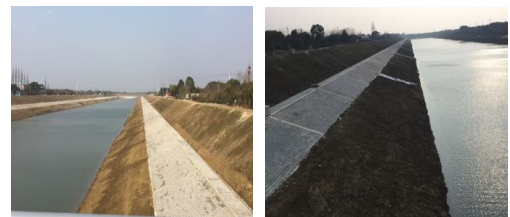
图 2 新孟河延伸拓浚工程云南段黏土包坡护岸
