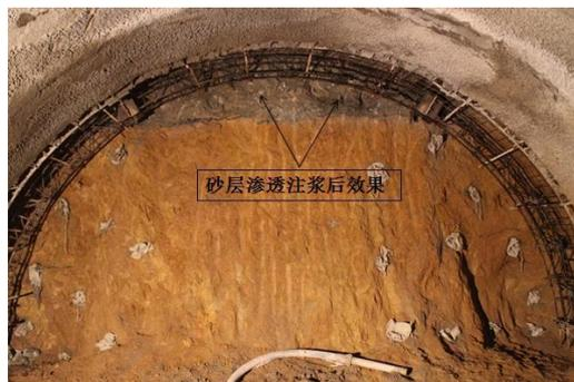
图 8 注浆加固后开挖图
