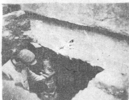
图1 坑下压桩情景
