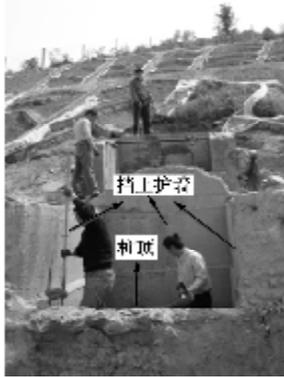
图 11 对桩顶有一定约束作用的挡土护壁
