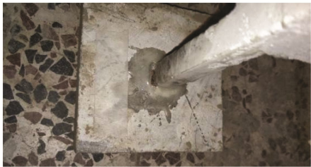
(a) 常规框架结构柱底破坏
