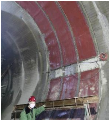
图 5 内水加载系统安装图
