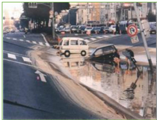
图5 顶板塌陷引起的地面沉降图
