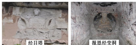
图6 小佛湾造像砂岩表面粉化剥落
