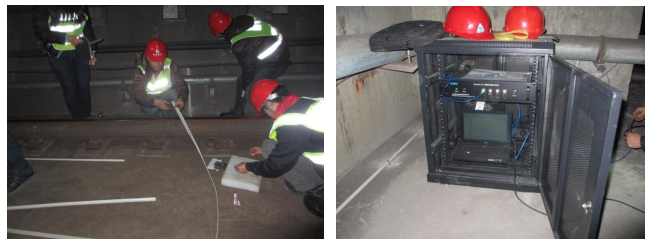
图 2 传感器及解调仪现场安装图
