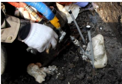
图 7 改性聚酯注浆地基加固施工中
