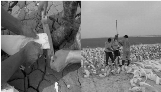
图 3 排水板端头包裹及打设
