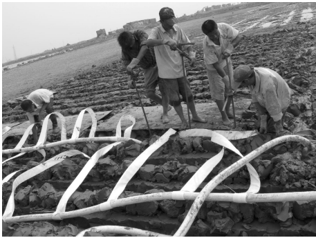
图 5 排水板打设和滤管踩入
