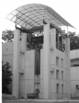
图 1 建成后的模型槽
