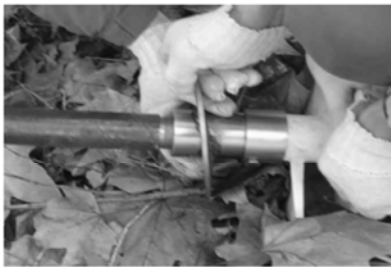
图3 准备安装螺旋锚
