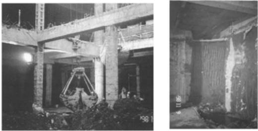
图 10 施工工况现场实景
