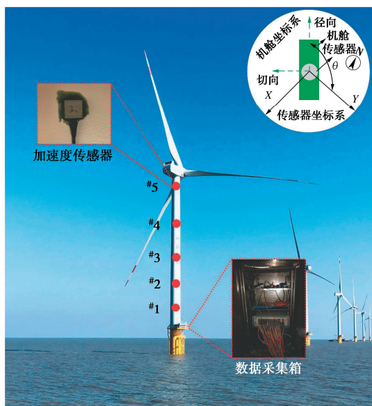
图2 海上风电结构及测点布置示意图
