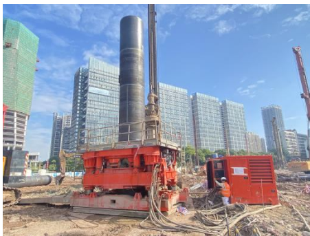
图 3 #QZ745 全套管灌注桩试桩施工
