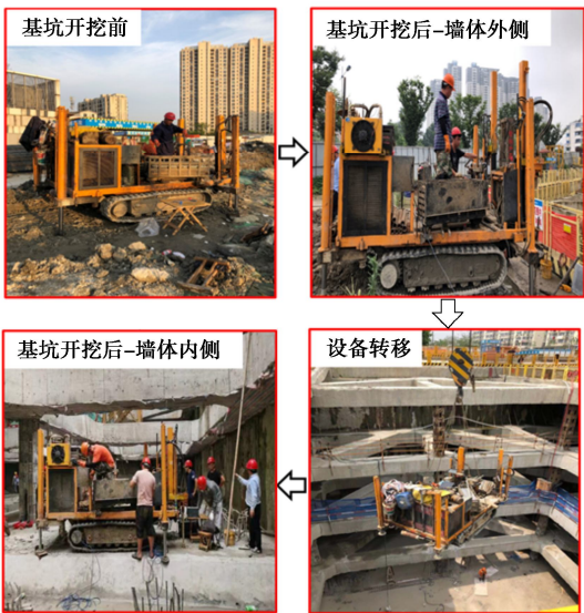
图7 邻近地铁车站深基坑 CPTU 测试过程
