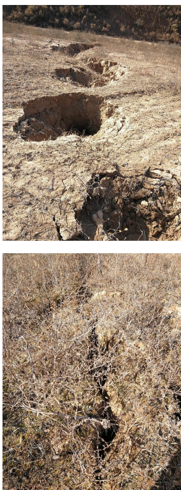
图 1 “治沟造地”工程管涌与裂缝破坏
