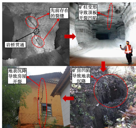
图 1 深部高湿环境裂隙矿柱水化侵蚀所带来的危害 [9]
