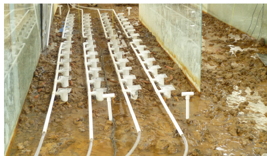
图 7 注浆管路的现场布置图
