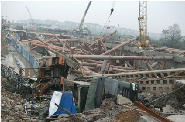
图 4 湘湖基坑倒塌现场 [15]
