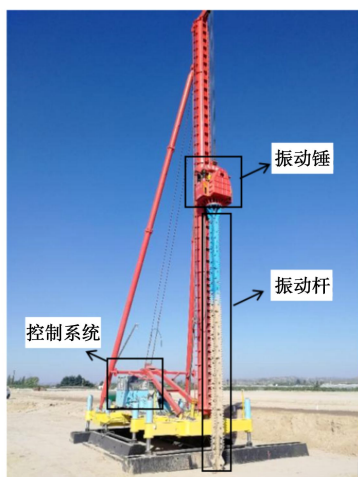
图 2 湿陷性黄土地基处理施工装备
