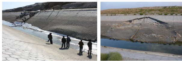
图 2 北疆某供水总干渠典型破坏照片
