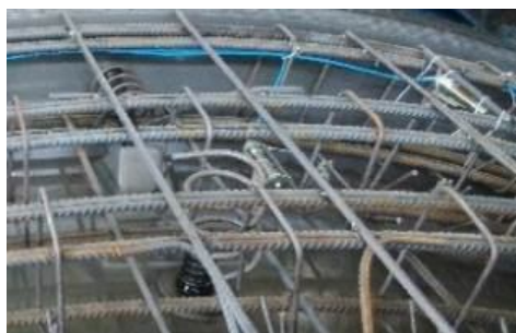
(a) 管片厂安装混凝土应变计
