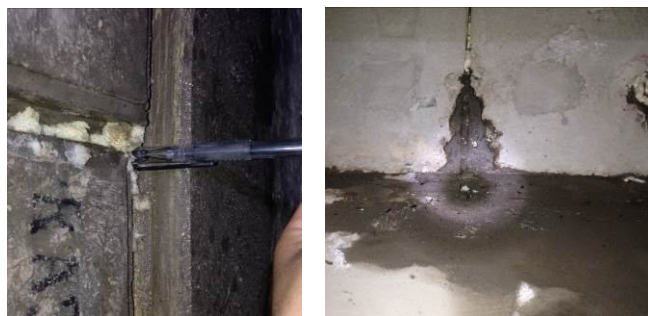
图4 接缝张开与错位导致渗漏水
