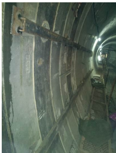
图 7 利用型钢纵向拉紧衬砌
