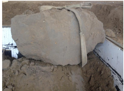
图 5 开挖后的水泥固化风积沙地基
