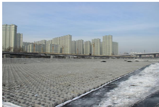
图2 铰链式混凝土沉排照片
