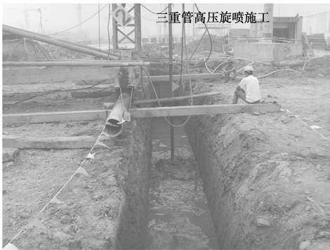
图 5 止水帷幕施工现场照片
