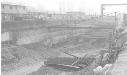
图1 车站深基坑现场照片
