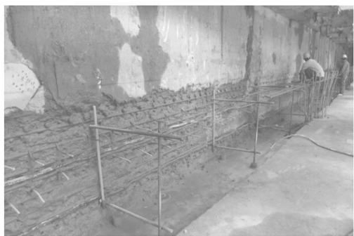
图2 某工程地下连续墙墙身、墙幅接缝渗水现象
